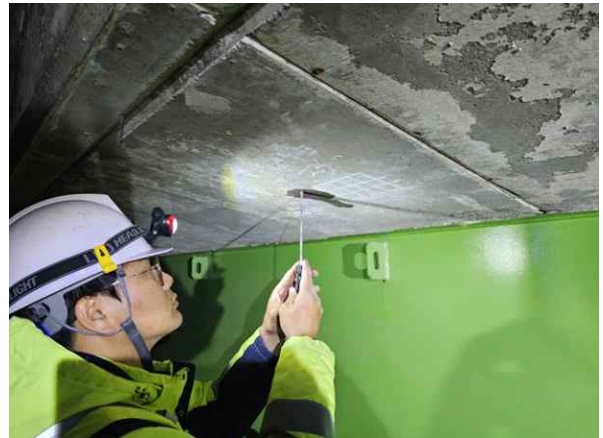
탄산화깊이 측정 현황
